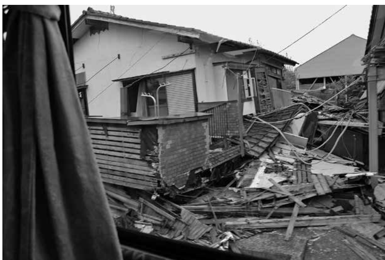
車窓から見ても悲惨な被害状況＝2016年5月3日、熊本県益城町、澁谷俊彦氏提供
